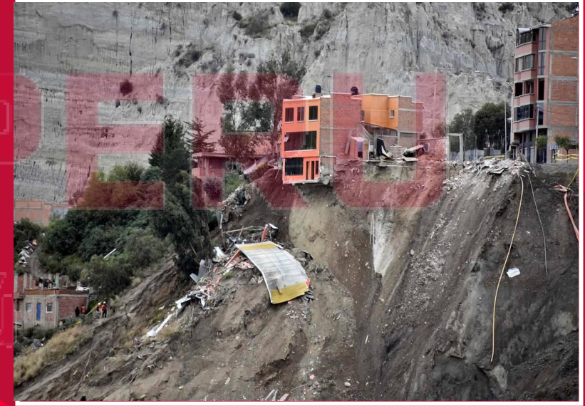
Colapso de vivienda
